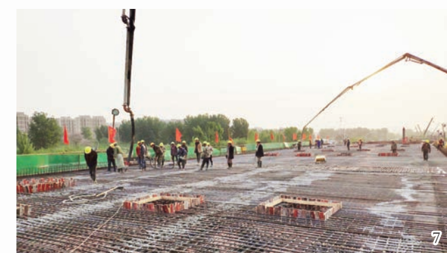
图1:4月17日,西四环快速化工程第一标段一工区现浇梁钢筋绑扎 (隧道公司 马勇摄) 图2:4月16日,大河路快速化工程第二标段零号块横梁验收 (第五分公司 杨国辉摄) 图3:4月16日,大河路快速化工程第二标段预制横梁钢筋吊装 (第五分公司 杨国辉摄) 图4:4月11日,大河路快速化工程第三标段预制节段梁一号块吊装 (第五分公司 谢蕊摄) 图5:4月17日,大河路快速化工程第八标段主线桥首联节段预制梁拼装 (第六分公司 郑梦梦摄) 图6:4月13日,大河路快速化工程第七标段预制梁拼装 (中豫路桥公司 张标摄) 图7:4月20日,大河路快速化工程第二标段现浇箱梁混凝土浇筑 (第五分公司 杨国辉摄) 图9:4月9日,大河路快速化工程第六标段架设一号块 (第一分公司 范桐赫摄) 图10:4月17日,西四环快速化工程第一标段一工区现浇梁钢筋绑扎 (隧道公司 张志远摄) 图11:4月4日,大河路快速化工程第三标段第14联左幅北侧防撞护栏开始浇筑 (第五分公司 谢蕊摄)
