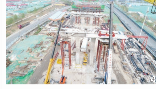
图1:4月17日,西四环快速化工程第一标段一工区现浇梁钢筋绑扎 (隧道公司 马勇摄) 图2:4月16日,大河路快速化工程第二标段零号块横梁验收 (第五分公司 杨国辉摄) 图3:4月16日,大河路快速化工程第二标段预制横梁钢筋吊装 (第五分公司 杨国辉摄) 图4:4月11日,大河路快速化工程第三标段预制节段梁一号块吊装 (第五分公司 谢蕊摄) 图5:4月17日,大河路快速化工程第八标段主线桥首联节段预制梁拼装 (第六分公司 郑梦梦摄) 图6:4月13日,大河路快速化工程第七标段预制梁拼装 (中豫路桥公司 张标摄) 图7:4月20日,大河路快速化工程第二标段现浇箱梁混凝土浇筑 (第五分公司 杨国辉摄) 图9:4月9日,大河路快速化工程第六标段架设一号块 (第一分公司 范桐赫摄) 图10:4月17日,西四环快速化工程第一标段一工区现浇梁钢筋绑扎 (隧道公司 张志远摄) 图11:4月4日,大河路快速化工程第三标段第14联左幅北侧防撞护栏开始浇筑 (第五分公司 谢蕊摄)
